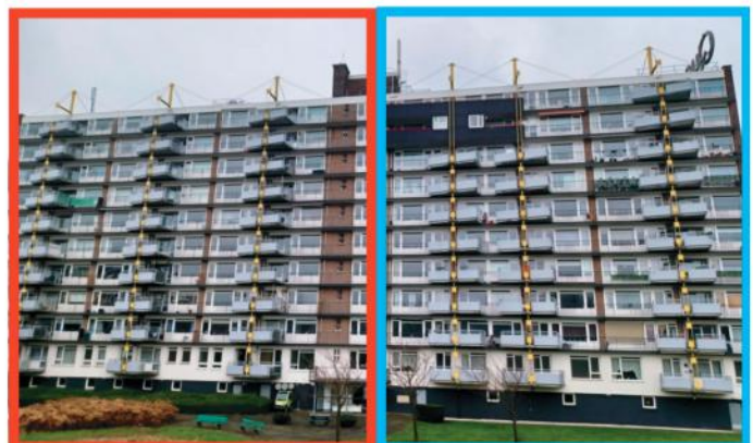
Achterzijde woongebouw deel 1 rood en deel 2 blauw
