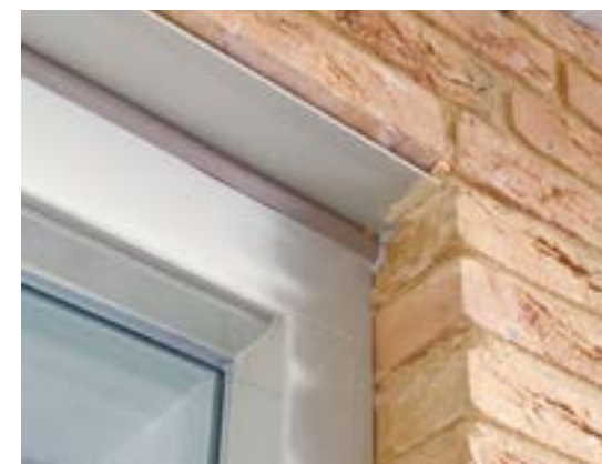
Achter de grijze kit in de hoek van het raam zit de bedrading voor de zonnewering. Deze draad is verbonden met de schakelaar aan de binnenzijde van de woning.
