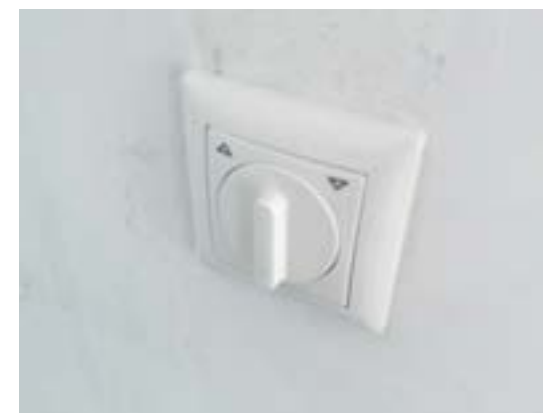
De schakelaar van de zonnewering in uw woning.
