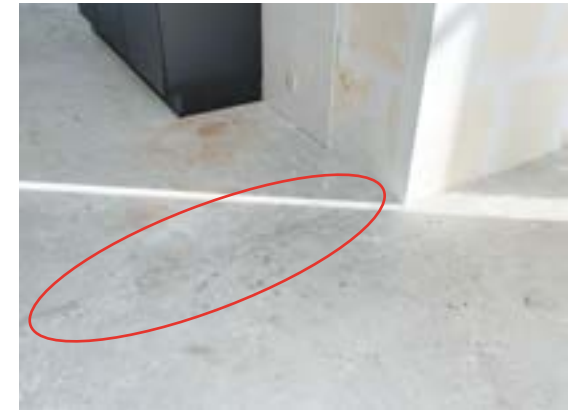
Op dit stuk hout in de vloer kunt u eventueel een extra wand maken.
